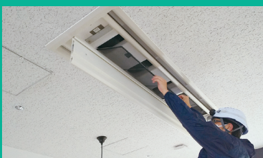
安全のために外構を施した体育館のエアコン設置工事の様子
