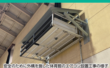
安全のために外構を施した体育館のエアコン設置工事の様子
